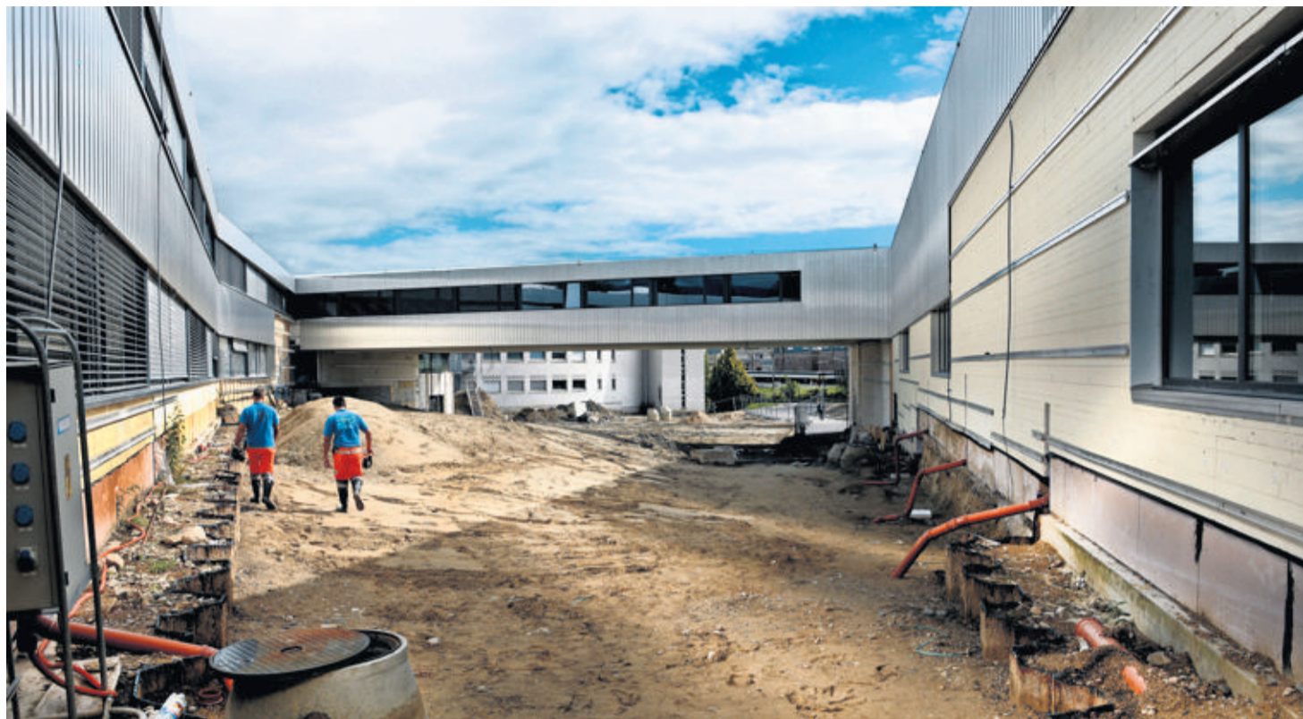
Dès le mois d'octobre, l'Atrium, construit en annexe du gymnase, accueillera étudiants et apprentis. ALAIN ROUÛCHE
